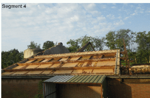
foto 3: Loopstal - Golfplaten en gordingen verwijderd.
