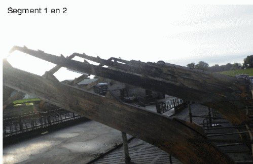
foto 5: Loopstal - Golfplaten en gordingen verwijderd.
