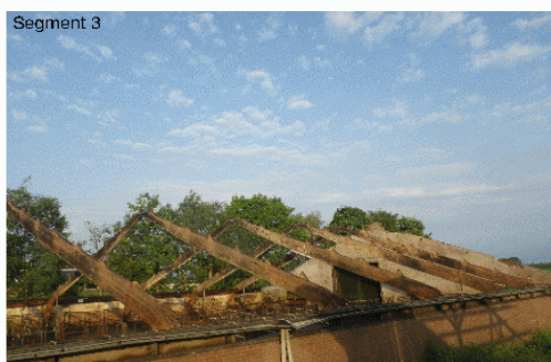
foto 4: Loopstal - Golfplaten en gordingen verwijderd.
