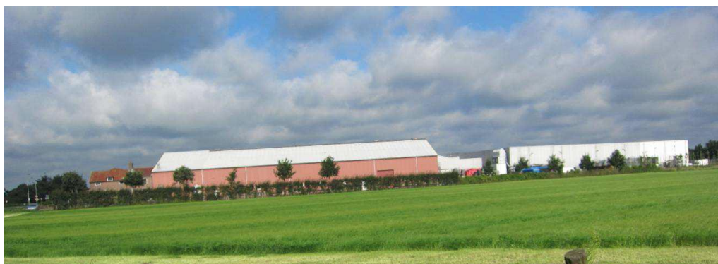
Figuur 6: Zicht op zijkant (oostzijde) Van Dijks Koelhuis en Tapkoelholding
