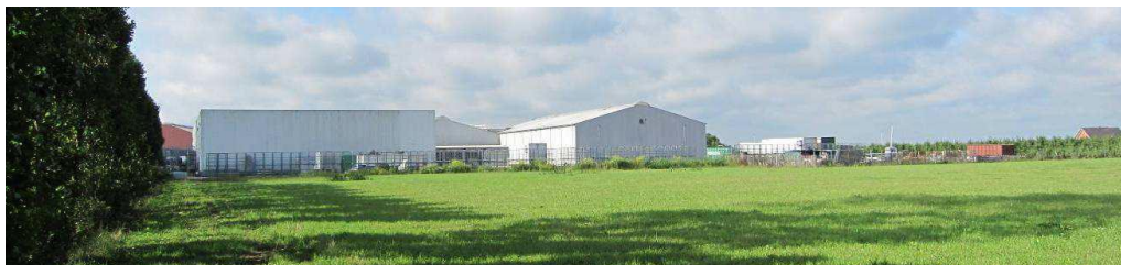
Figuur 5: Zicht op achterzijde (noordkant) Van Dijks Koelhuis en Tapkoelholding
