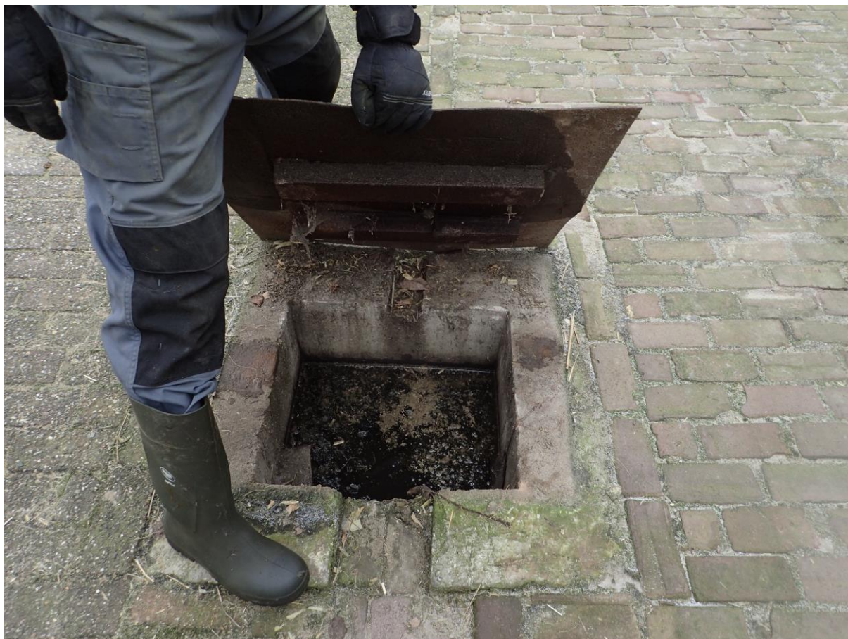
Waterput op het voorterrein
