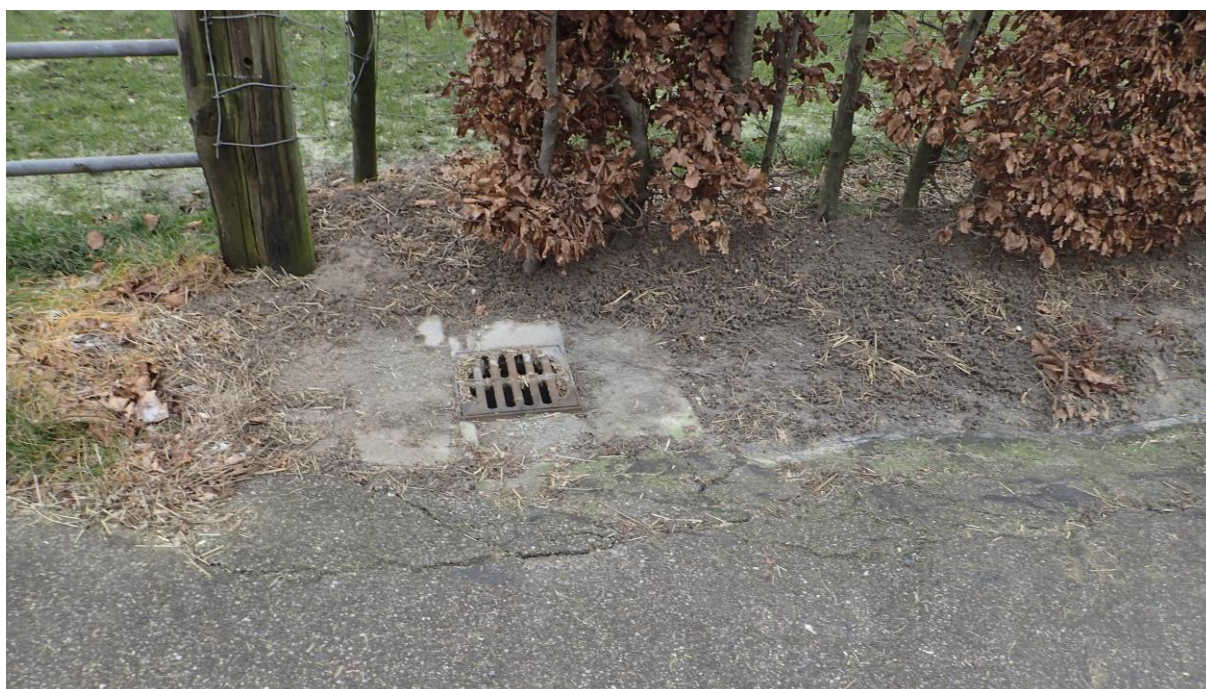
Drainage langs de westgrens van het perceel.
