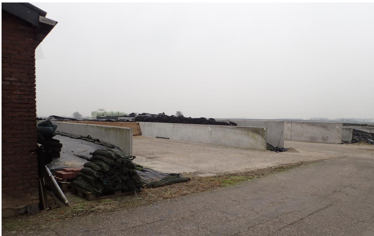
Sleufsilo's ingegraven in het maaiveld op het achterterrein.
