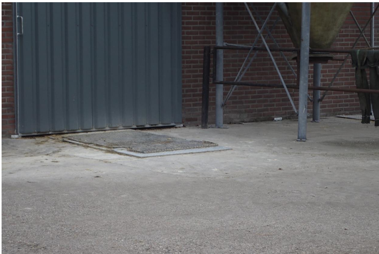
Putten op het erf achter de meest oostelijke loods
