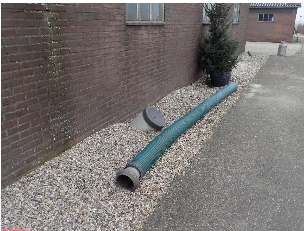
Luchtputten onder de schuur
