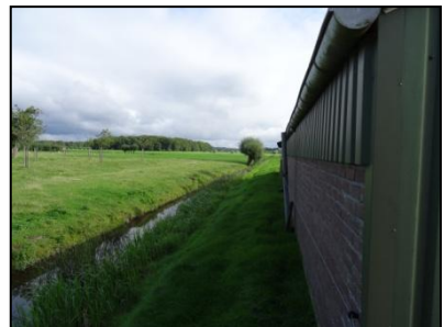
Figuur 17. Overzicht onderzoekslocatie, westzijde.
