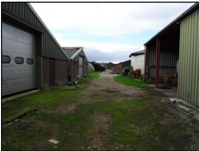
Figuur 21. Doorzicht onderzoekslocatie met diverse gebouwen, richting zuiden.
