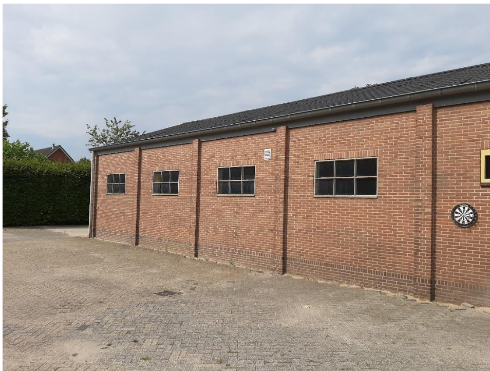
Foto 5; Dak bestaat metalen dakpan paneel.
