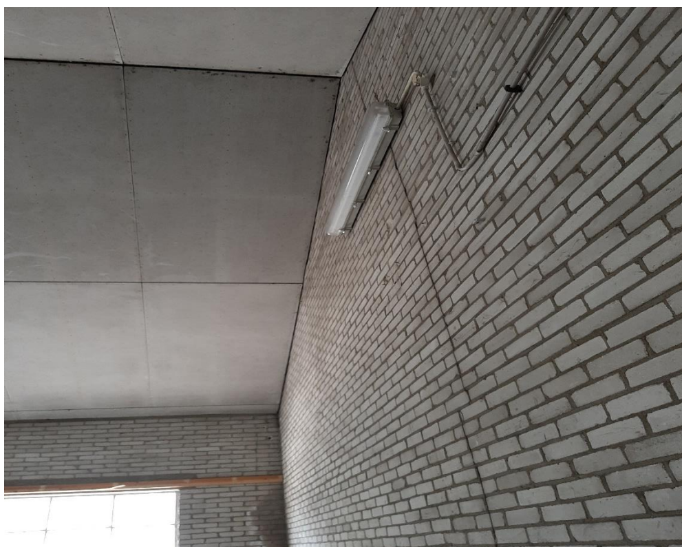
Foto 8: (asbesthoudend) dakbeschot
