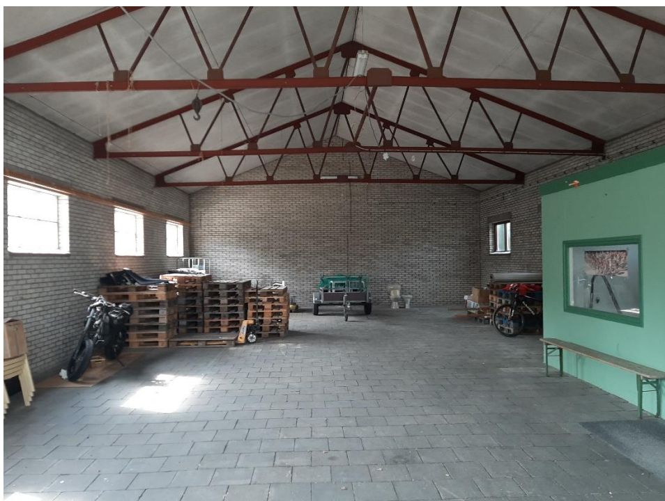
Foto 6: Binnenzijde gebouw geheel afgesloten.
