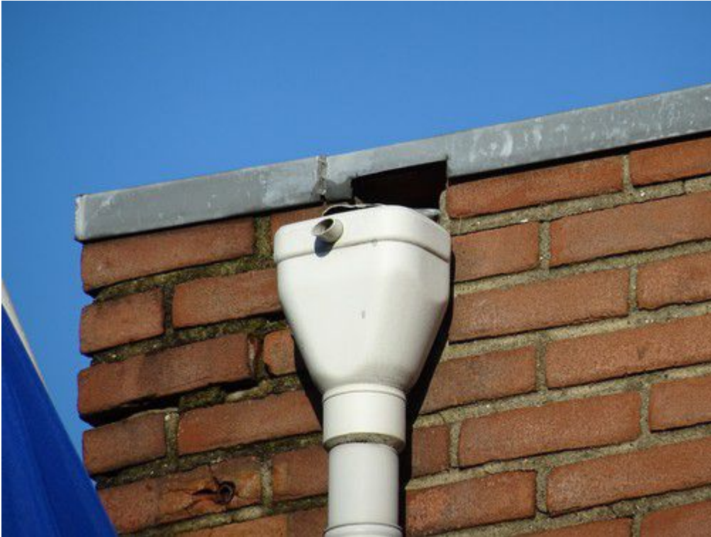
Ruimte boven regenafvoer die door huismus gebruikt kan worden als vaste rust- en verblijfplaats. Aan beide zijden naast deze regenafvoer bevinden zich open stootvoegen die toegankelijk zijn voor vleermuizen (niet op de foto)
