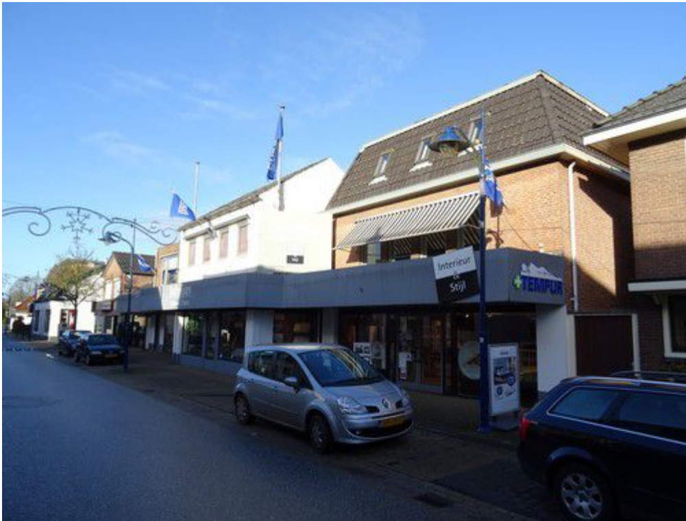
Vooraanzicht bebouwing Voorstraat
