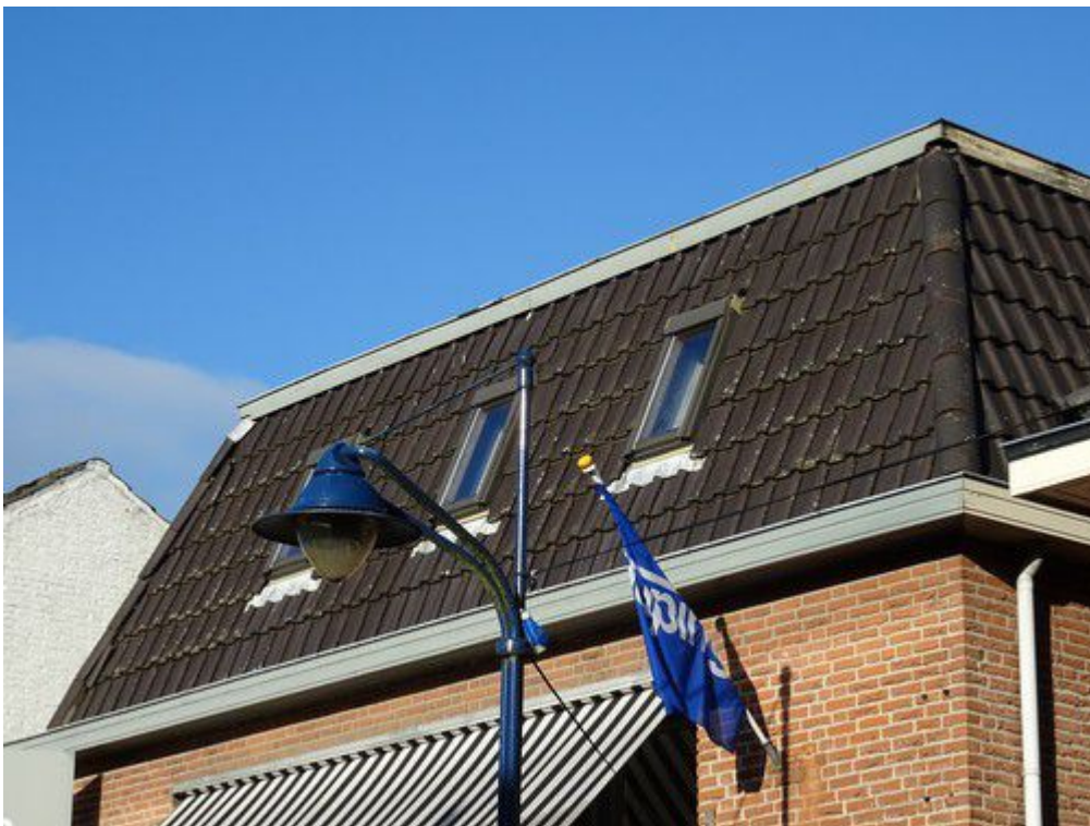
Schuin dak langs de Voorstraat met ruimtes voor vaste rust- en verblijfplaatsen van gierzwaluw onder de nok van het dak en loodflappen aan de zijkant van het dak
