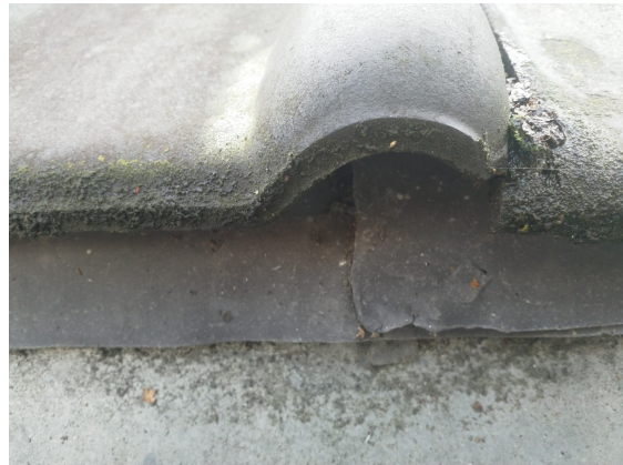
Afbeelding 2. Te kleine ruimte onder dakpan voor huismus (1 i.p.v. 3 cm). Foto F. van der Lans / Ecoresult B.V.
