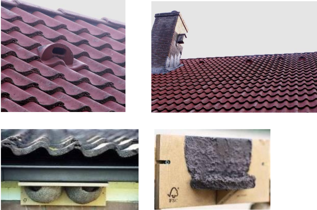
Figuur 9 Extra maatregelen voor broedvogels: gierwaluw, huiswaluw, huismus, dakpannen, nestkasten aan te brengen aan nieuw te bouwen woningen
