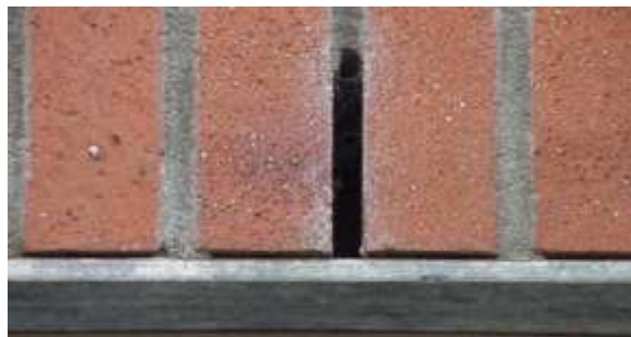
Figuur 8 Twee opties voor extra maatregelen voor vleermuizen. Links: een voorbeeld van een vleermuiskast. Rechts: Voorbeeld van een open stootvoeg. Achter de voeg moet een ruimte van circa 40*40 cm zonder isolatiemateriaal zijn zodat de spouw toegankelijk is.
