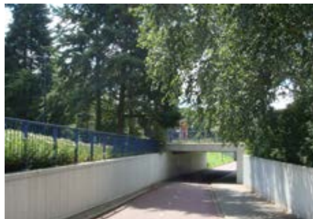
Zicht op de fietstunnel vanaf het noorden
