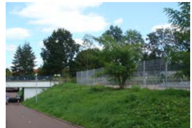
Zicht op de fietstunnel vanaf het zuiden
