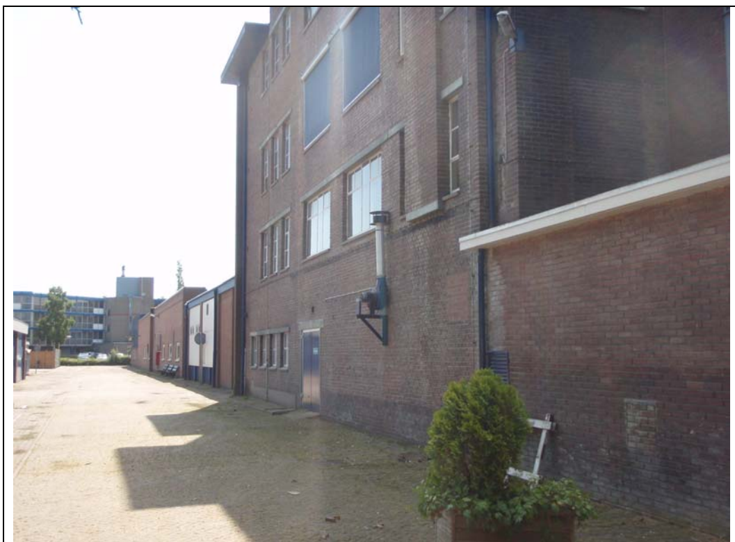
Foto: aanzicht fabriek noordzijde
