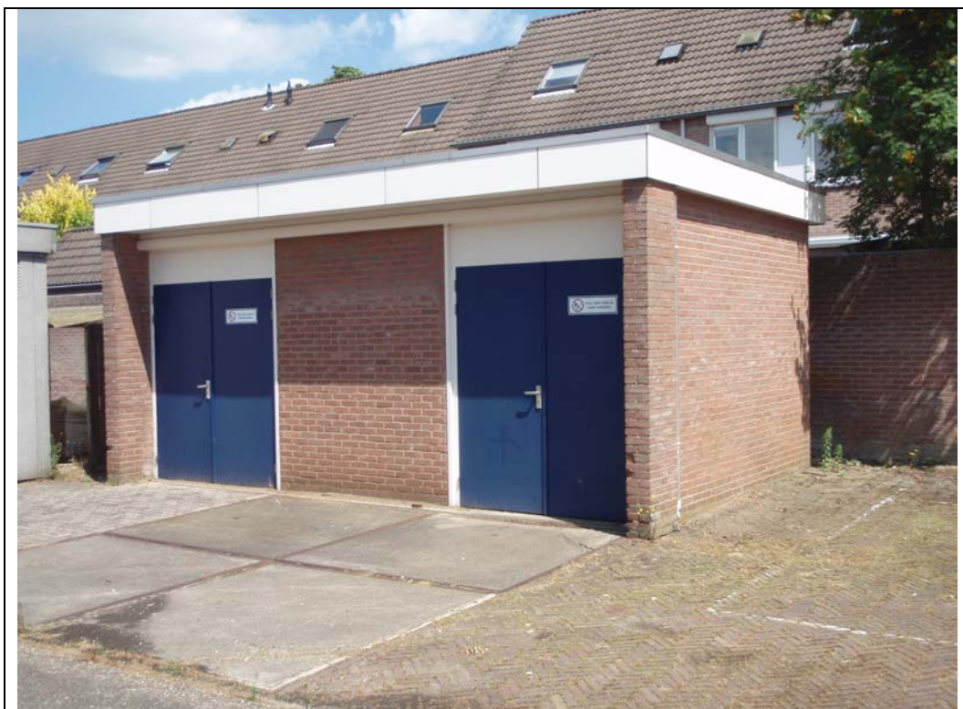
Foto: aanzicht bergingen (deels niet toegankelijk)
