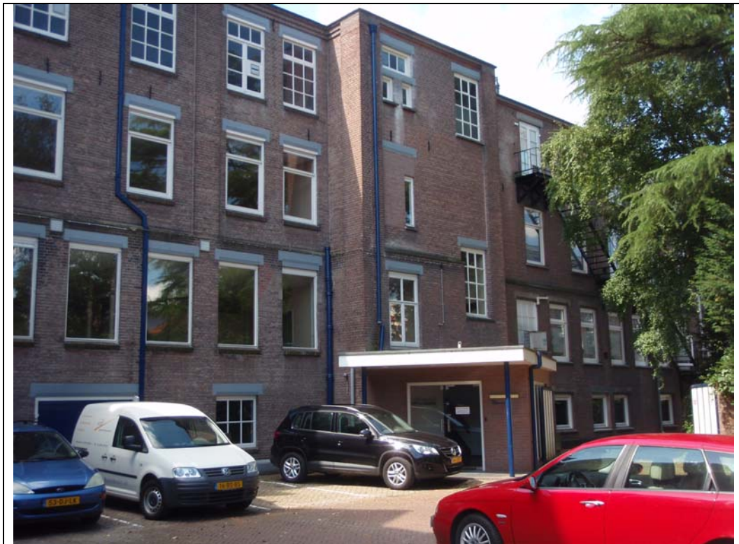
Foto: aanzicht kantoorgedeelte
