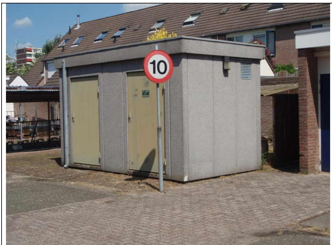
Foto: aanzicht transformatorgebouw (niet toegankelijk)
