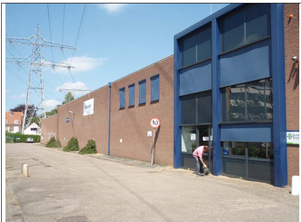
Foto: aanzicht fabriek zuidzijde
