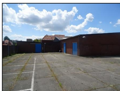
Figuur 10. Opslagplaats noordzijde.
