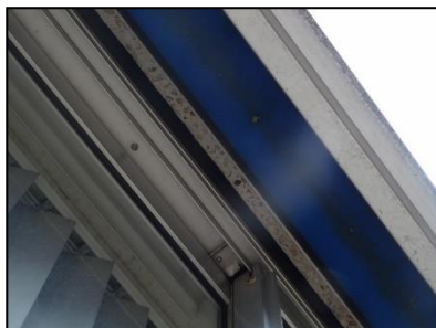
Figuur 15. Opening boven ramen in het kantoorgebouw.
