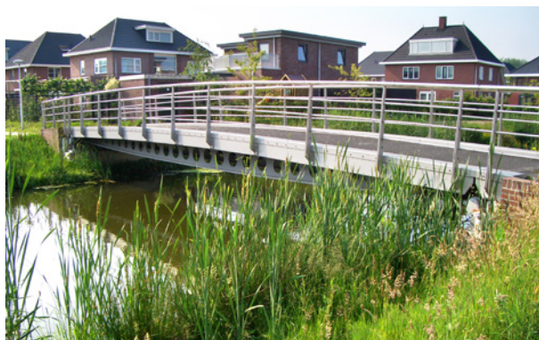
De autobridgen zijn helder, eenvoudig en lichtvoetig qua vormgeving en detaillering.
