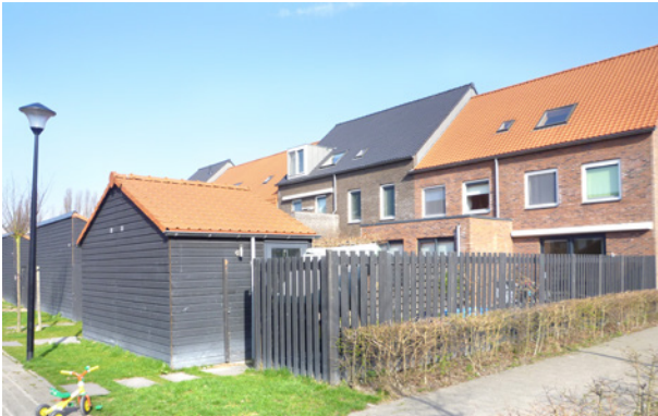
Bergingen en garages zijdelings grenzend aan openbaar gebied zijn meeontworpen met de architectuur van de bebouwing en hebben een kap.
