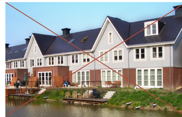
Ondanks variatie in kapvorm is er sprake van een doorlopend dakvlak, waardoor het gebouw als één geheel oogt.
