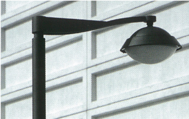
Een voorbeeld van een hoogwaardig armatuur voor de buurtontsluiting (6.00 m)
