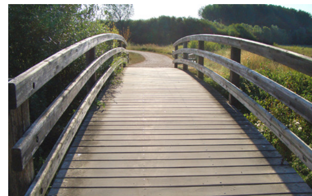
De bruggen hebben een licht gebogen brugdek en het basismateriaal is composiet, staal en / of beton.
