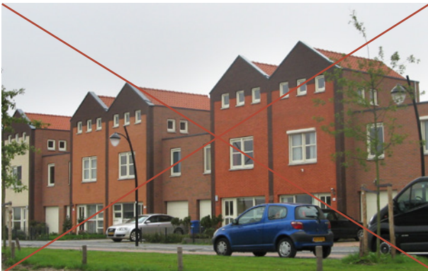
Garages met een volledige tweede laag zonder kap ondermijnen een dorpse schaal en maat van de bebouwing.
