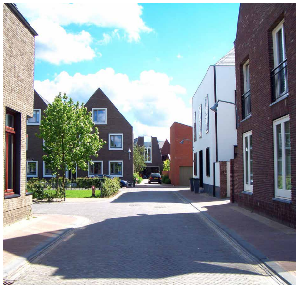
In het profiel wordt één basismateriaal van bij voorkeur gebakken klinkers toegepast.
