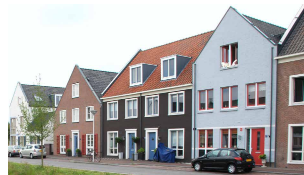
Variatie in dakvorm en een duidelijke beëindiging van de gevel draagt bij aan een 'stedelijk' dorps beeld.
