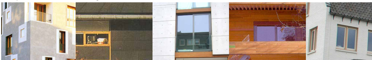
Ook gevelvlakken die niet in baksteen uitgevoerd worden, passen binnen de tinten van het kleurenpalet.
