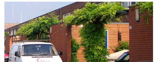
Kavels die direct aan de binnenhof grenzen hebben een carport op eigen terrein. De erfafscheidingen die grenzen aan de binnenhoven hebben een groene uitstraling.
