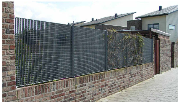
De bergingen aan de binnenzijde van een bouwblok zijn in samenhang vormgegeven en vormen een geheel.
