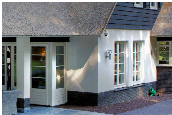
Vershil in materiaalgebruik tussen plint, begane grond en verdieping leidt tot een driedeling per woning.
