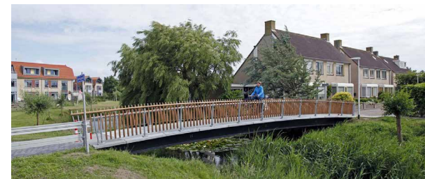
De langzaamverkeersbruggen hebben een gebogen brugdek en het basismateriaal is houtcomposiet of staal. (beeld ipv Delft)
