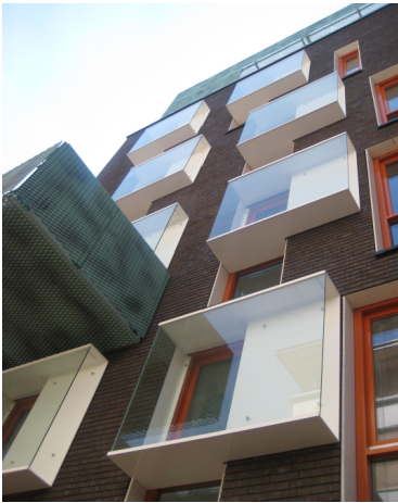
f5.3 Geluiddempende constructie 'Het Kabinet' Paleiskwartier Den Bosch
