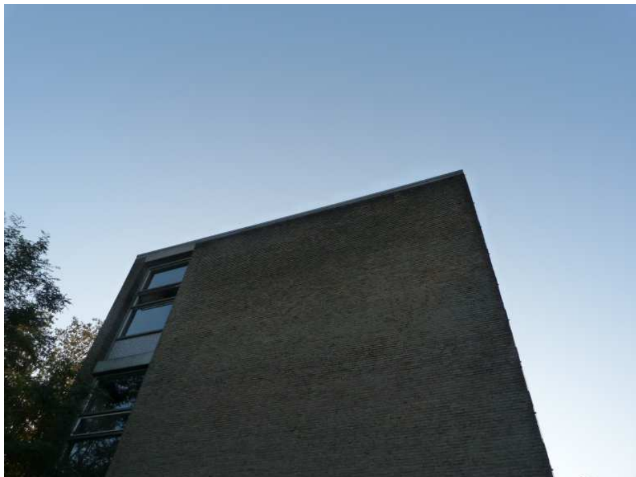
Figuur 5: Westelijke gevel CSV-gebouw. Hier bevindt zich een paarverblijfplaats: mogelijk achter de gevelplaten bij de ramen.
