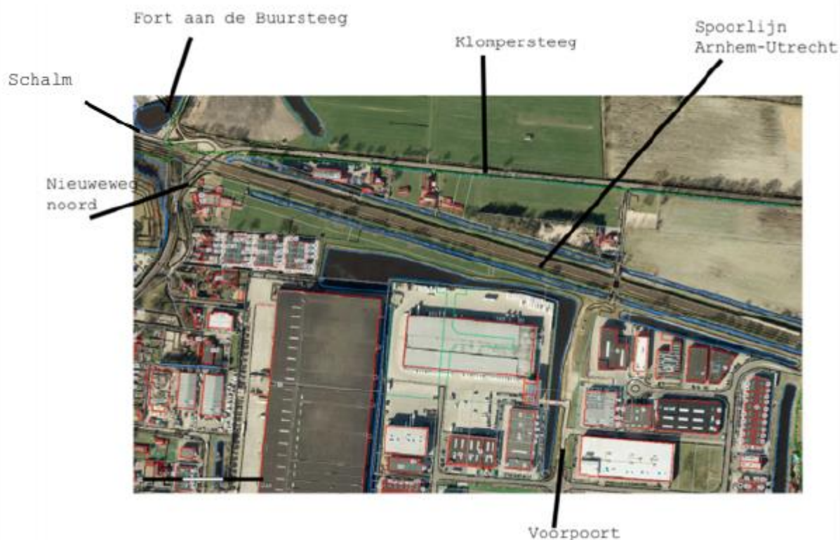
figuur 3.2 Luchtfoto spoorwegovergangen en omgeving, links de spoorwegovergang Nieuweweg Noord, rechts de spoorwegovergang Voorpoort (gemeente Veenendaal, 2015)
