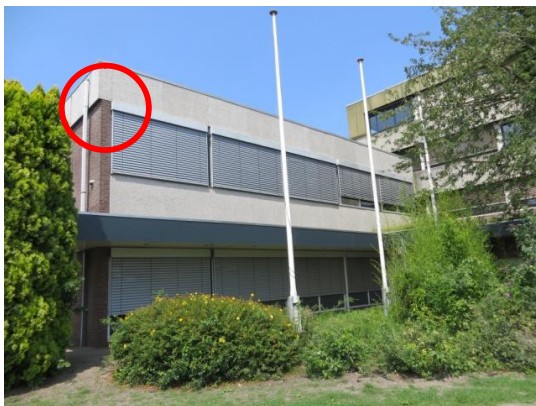
Foto 7 & 8 gevel met opening achter de gevelplaat
