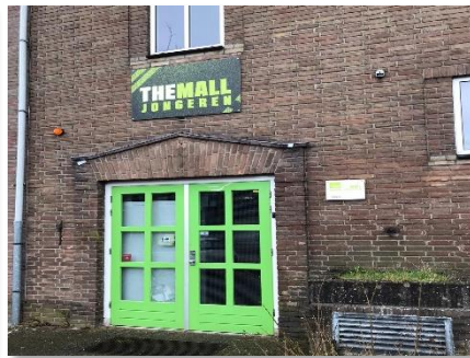
Foto 2: Impressie plangebied (schoolgebouw hoofdingang).
