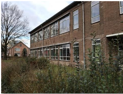
Foto 1: Impressie plangebied (schoolgebouw zij aanzicht).
