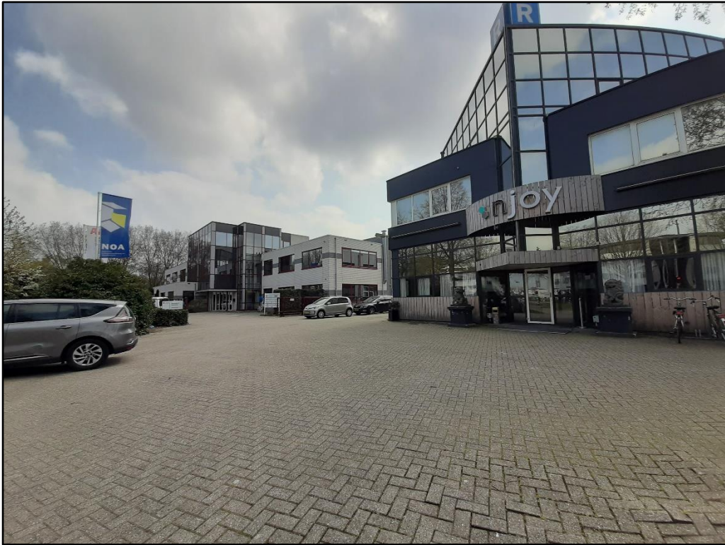
Figuur 1 De planlocatie is gelegen aan de Nieuweweg 222-226 te Veenendaal en bestaat uit een wok restaurant (rechts), een kantoorpand (links), parkeerplaatsen en enkele groenstructuren.
