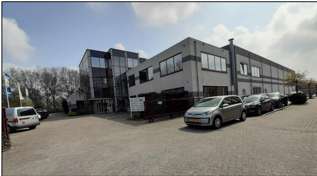
Figuur 2 Fotografische indruk van de planlocatie en de directe omgeving hiervan Boven: gebouw A (wok restaurant). Onder: gebouw B (kantoorpand).
