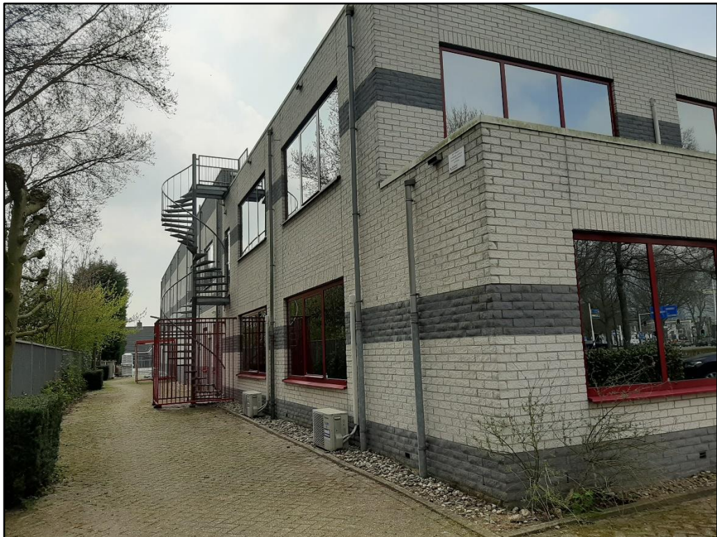
Figuur 4 Gebouw B, het kantoorpand, gezien vanuit het noordoosten.
