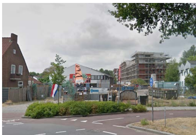
Inbreidingslocatie aan de 1e Melmseweg, waarvan het deel hier in aanbouw reeds gerealiseerd is.
