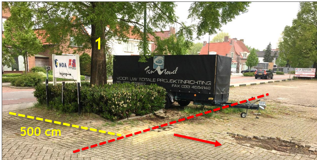
Afbeelding 21: Rood: grens ontgraving bouwput. Alle aanwezige wortels in de richting van de pijl worden verwijderd;
