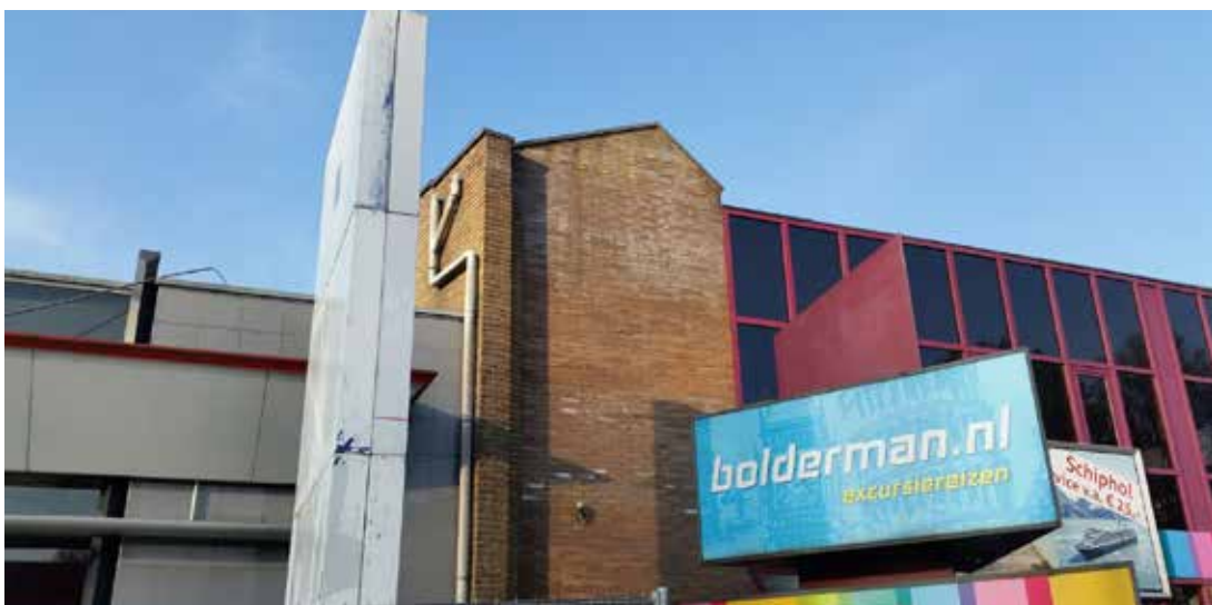
Gebouw 6, met licht afstaande dakranden.
