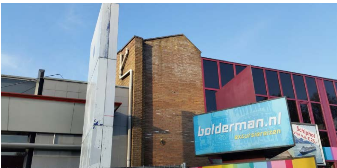
Gebouw 6, met licht afstaande dakranden.
