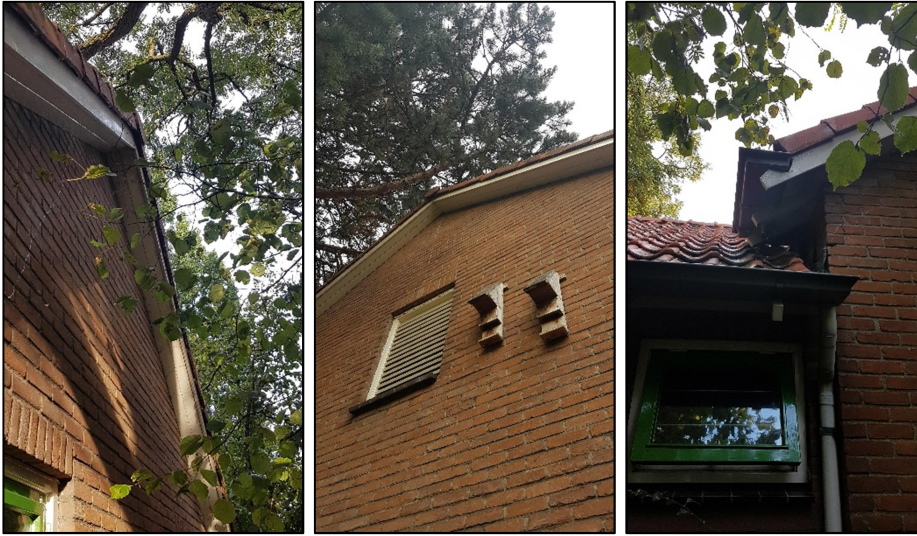
Figuur 3.1 Openingen naar achterliggende, mogelijk als verblijfplaats geschikte, ruimtes voor vleermuizen en de aanwezige vleermuiskasten
