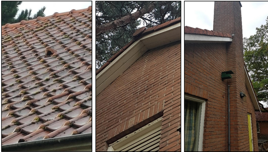
Figuur 3.5 V.l.n.r.: gierzwaluw-dakpan, sporen van gierzwaluw bij de opening naar het (mogelijke) nest en een nestkast voor huismus
