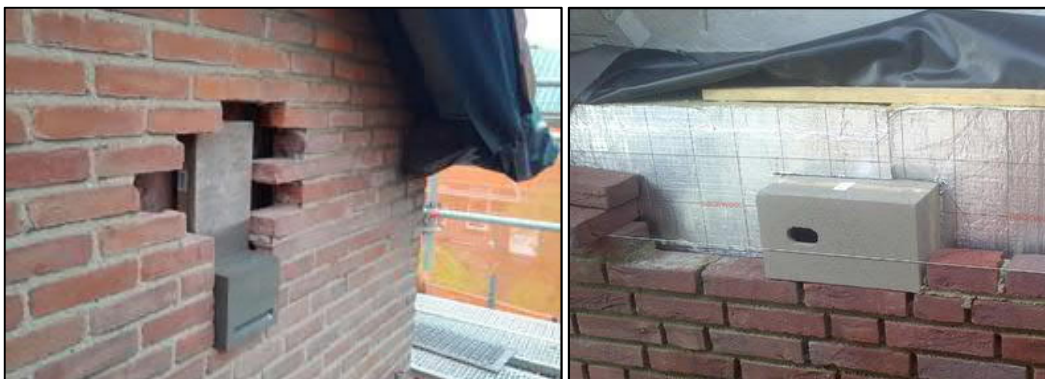
Figuur 5.1 Faunavoorzieningen voor gebouwbewonende soorten - een vleermuiskast (links) en een gierzwaluwkast (rechts)
