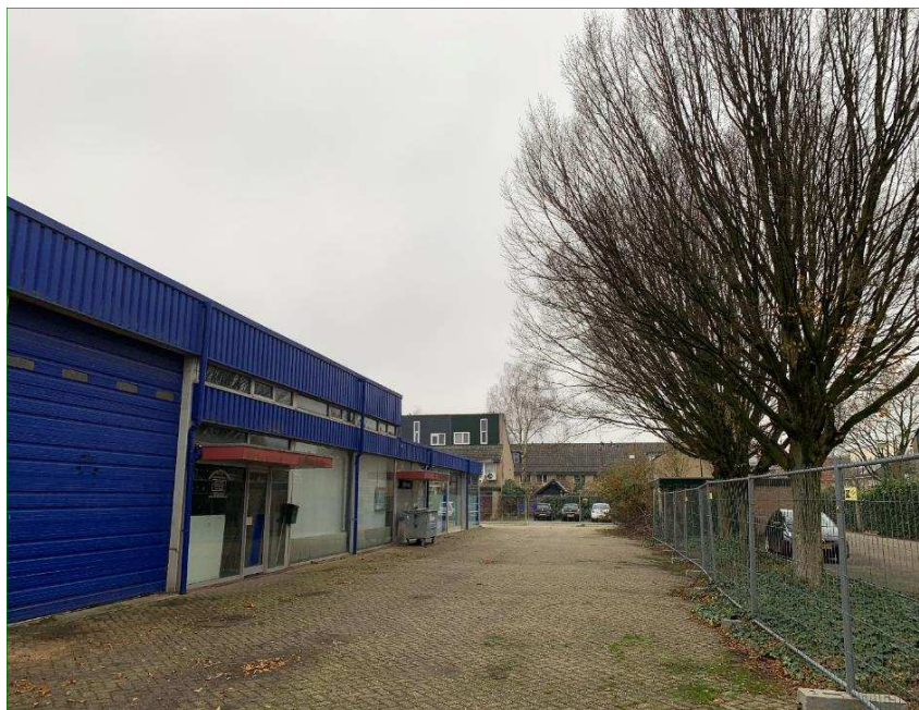
Impressie van het plangebied met links de te slopen bebouwing.
