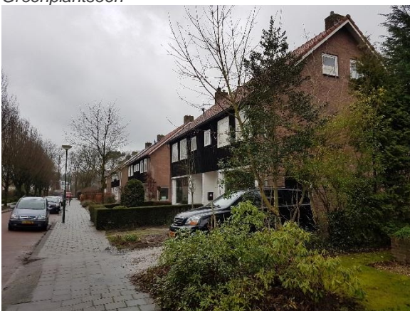
Twee-onder-een kap woningen
