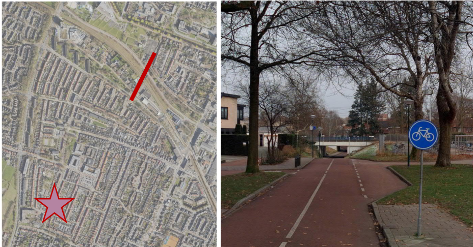
Figuur 3: De fiets- en voetgangerstunnel onder het spoor door in het verlengde van de Frans Halslaan.
