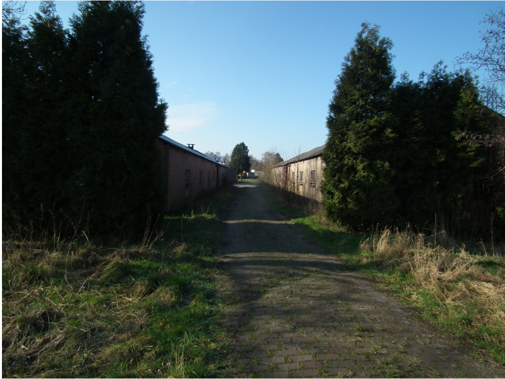
Figuur 1 De planlocatie is gelegen aan de Dragonderweg en Meentdijk te Veenendaal en betreft enkele opstallen, bijgebouwen en weide.
