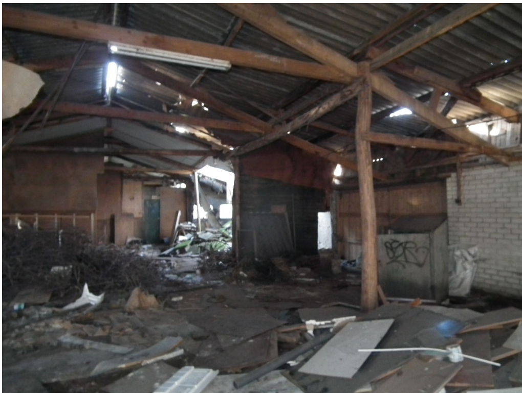
Figuur 4 Onder andere door achterstallig onderhoud en hevige stormen zijn grote delen van de opstallen beschadigd. Met name de westelijke opstal verkeerd in een vervallen staat.
