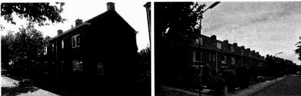
Figuur 2: impressie huidige situatie Dennenlaan en Sparrenlaan
