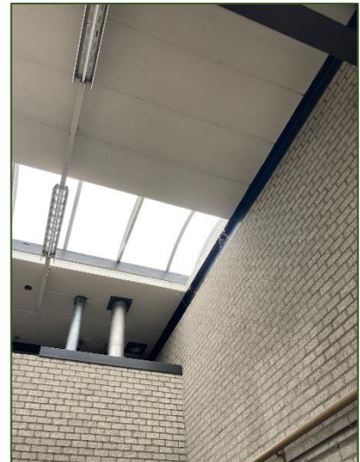
Fig. 2.14 Binnenzijde hal 2 (bron: FF Solutions)
