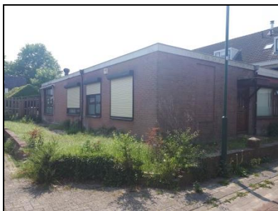
Figuur 3. De bungalow op onderzoekslocatie, gezien vanuit het noordoosten.
