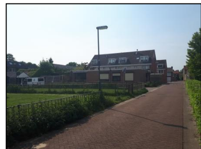
Figuur 8. Onderzoekslocatie en naastgelegen groen, gezien vanuit het oosten.
