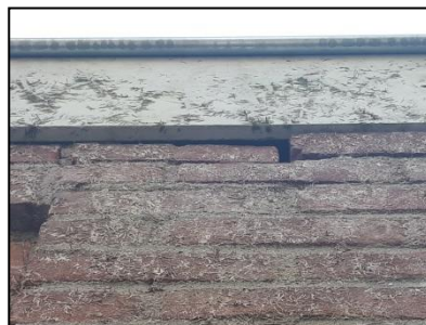
Figuur 7. Ruimte tussen betimmering en de gevel van de bungalow.
