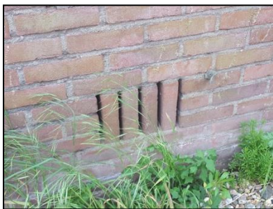
Figuur 6. Ontluchtingssluiven aan de onderzijde van de gevel van de bungalow.
