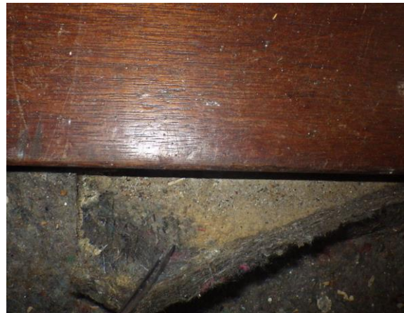
niet asbestverdachte lijm
