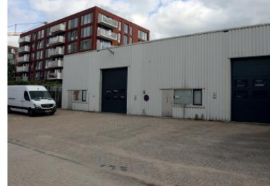
Bestaand pand - Parallelweg
