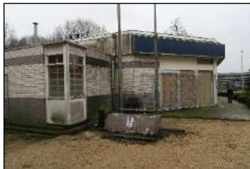
Foto 8. Gebouw aan de Industrielaan 1
