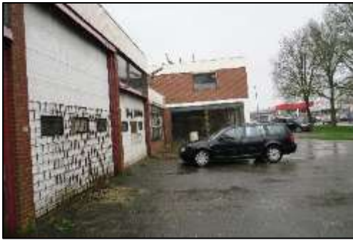
Foto 5. Gebouw aan de Industrielaan 1b
