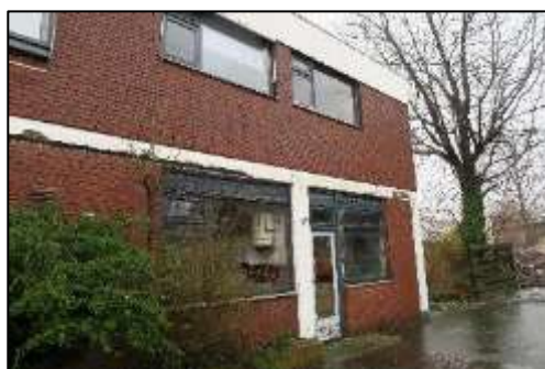
Foto 3. Gebouw aan de Industrielaan 1b
