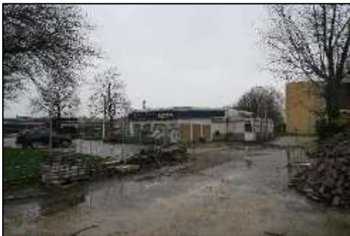
Foto 7. Gebouw aan de Industrielaan 1
