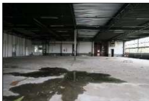
Foto 4. Binnenkant gebouw Industrielaan 1b
