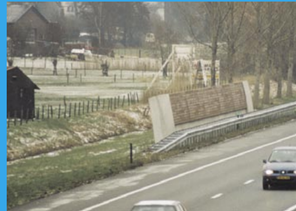
Geluidsscherm langs de A12 (prototype A30)
