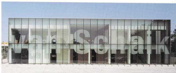
Middengebied: reclame uiting over gevelvlak
