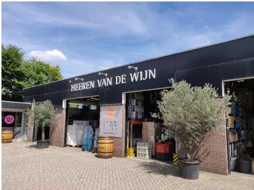
1 Voorkant van het gebouw.
