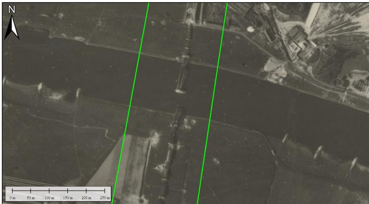
Figuur 23. De vernielde spoorbrug bij Rhenen op de luchtfoto van 19 april 1945. Van de brug was na de bombardementen en de vernielingspogingen door de Duitsers weinig meer over. De inslagkraters van het bombardement van 2 oktober 1944 zijn nog altijd zeer duidelijk te zien. Luchtfotonummer 4042.
