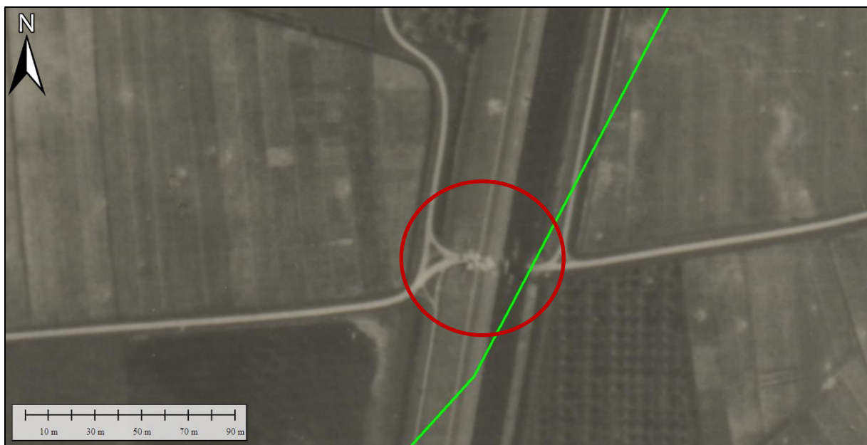
Figuur 56. Schade aan de noordelijke poort (rode cirkel) onder de spoordijk op 25 april 1945. Duidelijk te zien is dat er geen vernieling heeft plaatsgevonden op de schaal waarop dat met de zuidelijke poort is gebeurd. Luchtfotonummer 3006.
