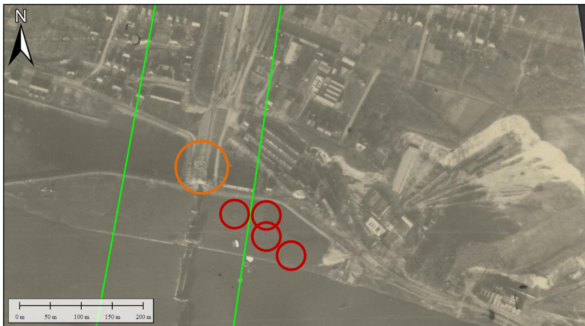
Figuur 32. Uitsnede van de luchtfoto van 23 december 1944 van de spoorbrug en de uiterwaard bij Rhenen. Met rode cirkels zijn enkele Duitse geschutopstellingen aangegeven, mogelijk dezelfde die Hollemans regelmatig noemt. Op de oprit naar de voormalige brug is met een oranje cirkel ook een loopgraaf aangegeven. Luchtfotonummer 3082.
