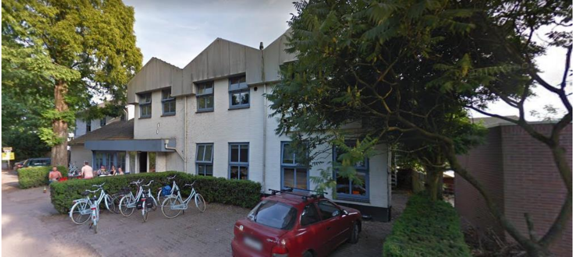
Afbeelding 1.3.4: Pand aan de 1 e Melmseweg nr. 10, in het noorden van het plangebied (Bron: Google Streetview).
