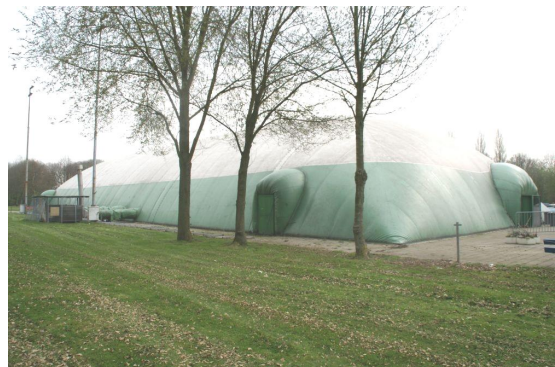
Foto 4. Grote bad is tijdelijk overdekt met tent.
