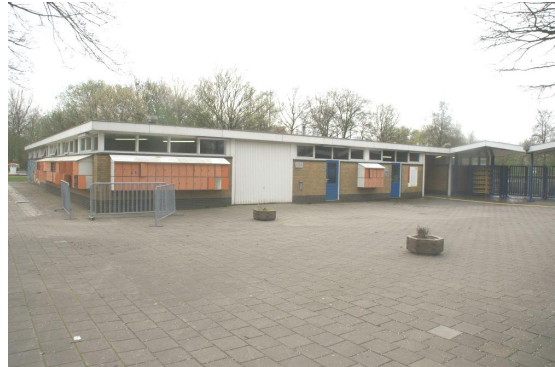
Foto 2. Garderobe en sanitair gebouw.
