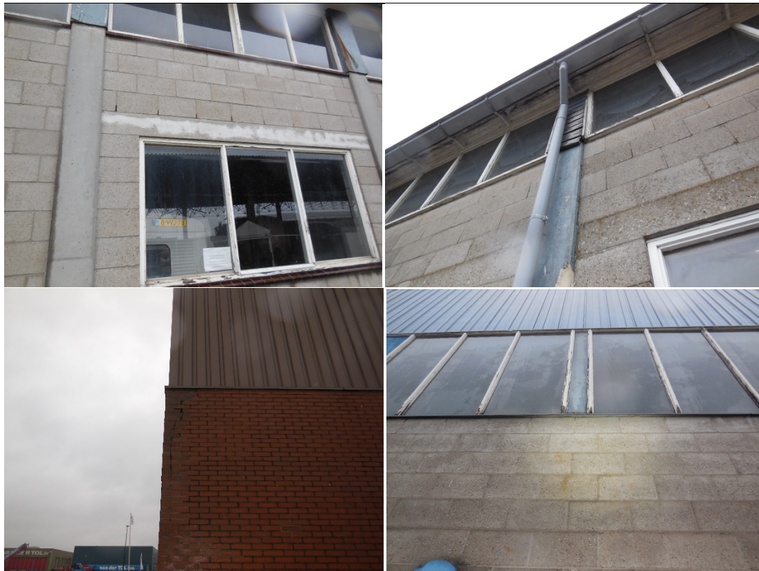
Figuur 3.2 Impressie van holtes en spleten die mogelijk als verblijfplaats voor vleermuizen zouden kunnen dienen
