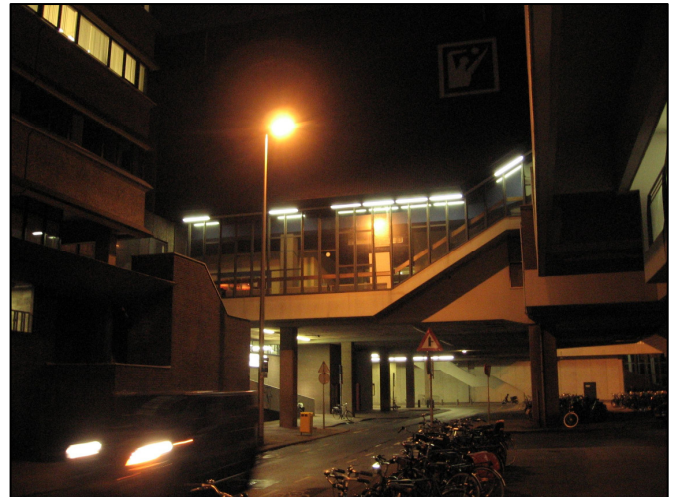
Figuur 3. Westelijk deel van Jaarbeurstraverse (bij locatie "sporthal") gezien vanaf Mineurslaan.
