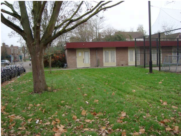
Foto 3. Zuidzijde plangebied met het voormalige culturele centrum en links de Schermerhornstraat.
