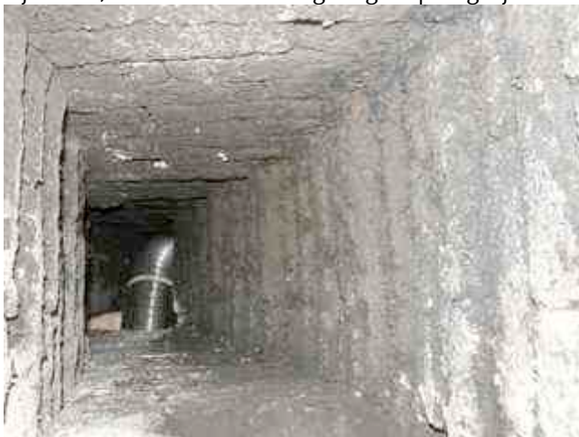
Foto 2. Binnenzijde rookkanaal in de schoorsteen.
