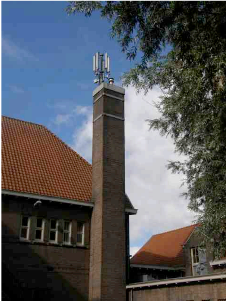
Foto 1. Schoorsteen op de Lindostraat nr. 4.
