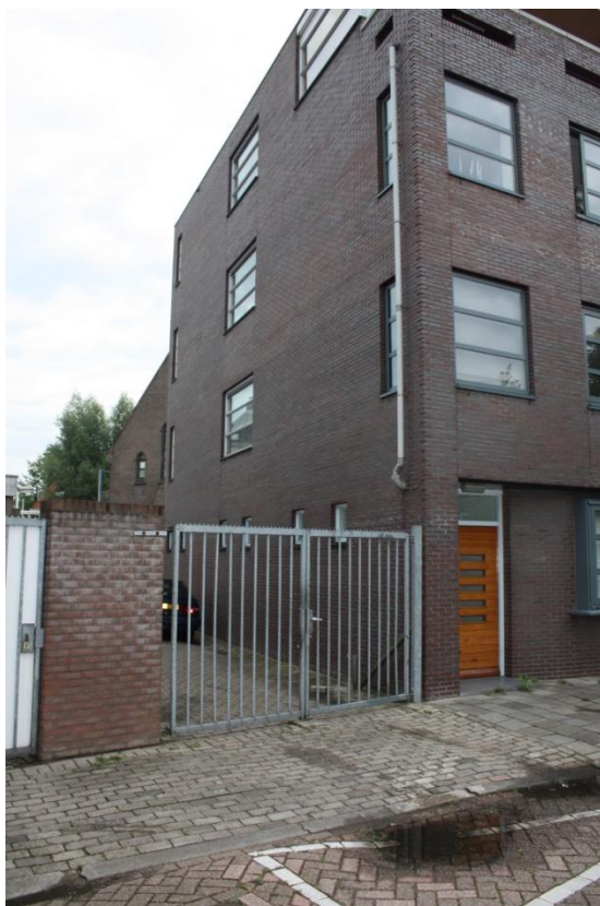
Beperkte gevelopeningen Oudwijk 49 t/m 55
