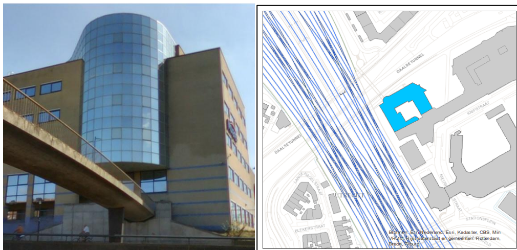
Figuur 5-2 Gevel Daalseplein 101 (links) en sporenlay-out ten tijde van de metingen (rechts)
