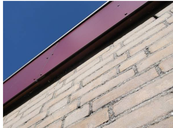
Foto 4: Bij de daklijsten van de laagbouw in fase 1 zijn geen openingen gevonden die groot genoeg zijn voor vleermuizen (alle gevonden openingen zijn < 1 cm).
