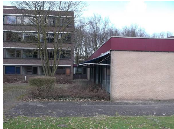
Foto 2: Op de voorgrond het kantoor van bouwdeel H, op de achtergrond staat bouwdeel F (links).
