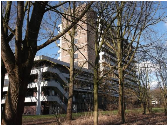
Foto 7: Fase 2, gezien vanaf het zuiden. Bij het trappenhuis en de balkons zijn betonnen voorzetplaten te zien, waarachter mogelijke verblijfplaatsen van vleermuizen zitten.
