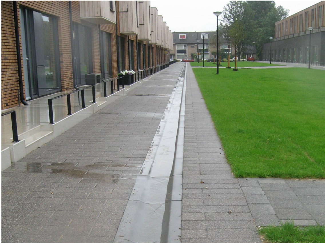
fig. 4 Bovengrondse afvoer ('t Podium Apeldoorn)
